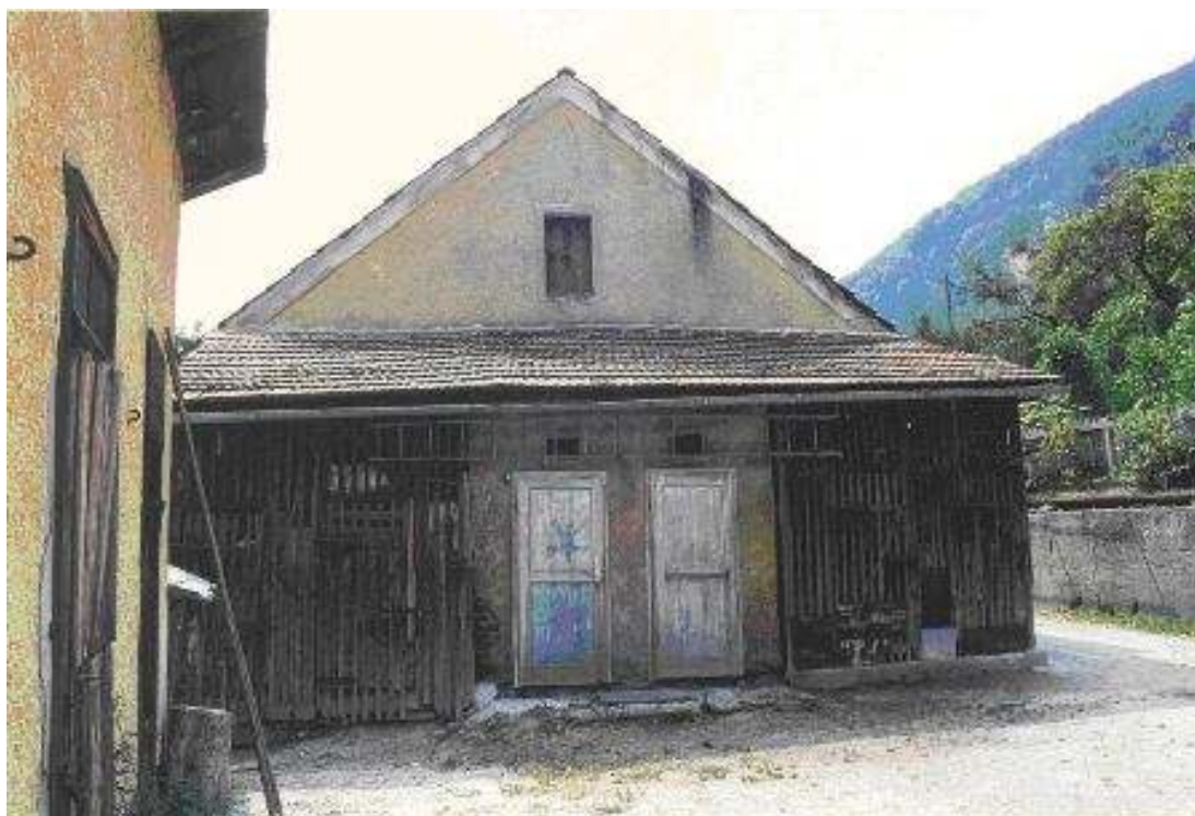
ZUNANJE STRANIŠČE IN BARAKE PRED OBNOVO
